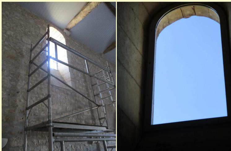
Depuis longtemps déjà, le vitrage des deux baies latérales de l'église laissait à désirer : armatures métalliques oxydées, vitres brisées ou fêlées, chute de matériaux, intrusion de volatiles ... Le remplacement des encadrements vétustes avec pose de vitres de sécurité a été confié à l'entreprise Arnaud, de Migron, pour un montant de 3 180 € TTC. L'apport bienvenu du mécénat rendra l'opération, une fois encore, quasiment indolore pour les finances communales.
