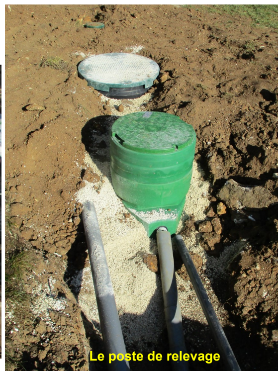
Le poste de répartition des effluents 12/11/2021
